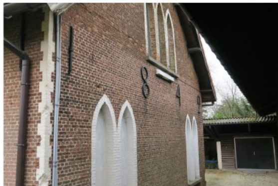
Het bouwjaar 1842 is met muurankers op de zijgevel aangebracht. FOTO JAA
